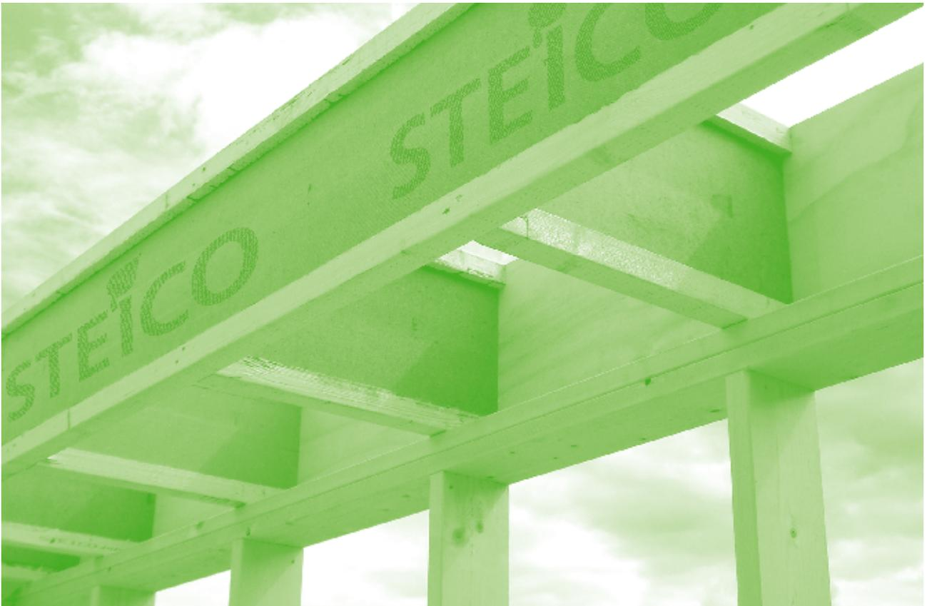
STEICOjoist ist ein geometrieoptimiertes Produkt nach dem Vorbild der Natur. Geeignetes Material wird nur an den Stellen eingesetzt, wo es zur Erfüllung seiner Aufgaben benötigt wird. Dies macht STEICOjoist zu einem schlanken, wirtschaftlichen Bauteil für den Einsatz in Decken.
