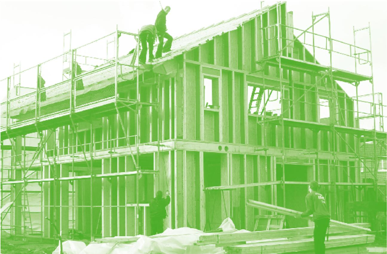
STEICO*wall* ist ein schlankes, wirtschaftliches Bauteil für den Einsatz in Wänden mit hohem Anspruch an energieeffizientes Bauen bei gleichzeitig hoher Tragfähigkeit. Der Einsatz des STEICO*wall* Dämmständers vereinfacht das Dämmen und trägt somit nochmals zur Kostenreduktion bei.
